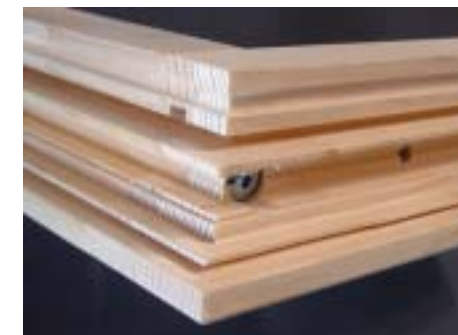
Verschraubter Fensterflügel mit Verklotzungsbohrung zur Scheibenfixierung
