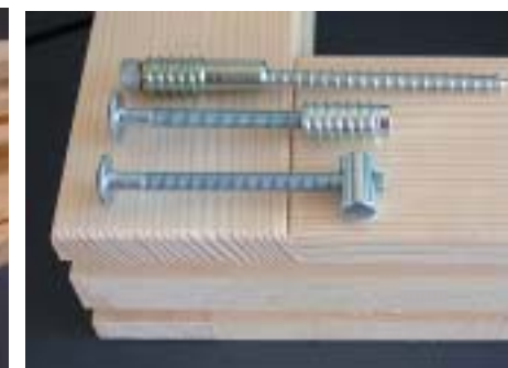
Beispiele für Schraubverbindungen
